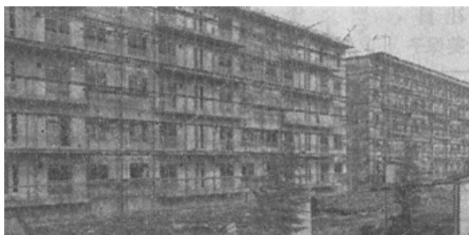
プレキャスト工法で建設中の高泉住宅（S.49）
