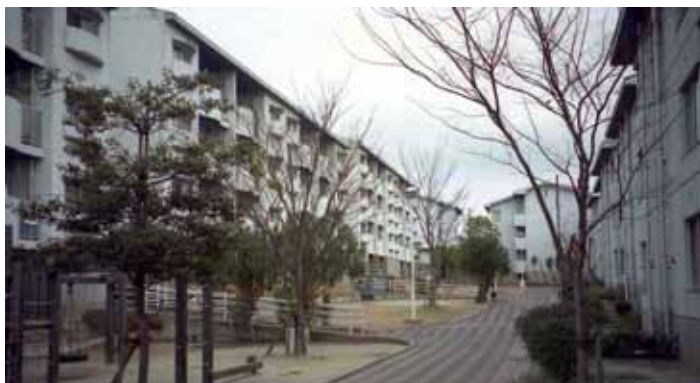
H O P E 計画に基づき建設された白銀住宅 ( H.6 )
