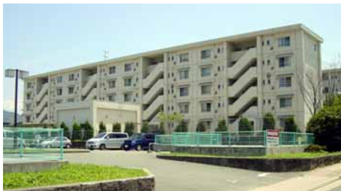
三井鉱山(株)七夕社宅跡地に建設された雇用促進住宅白川宿舎(H.18)
